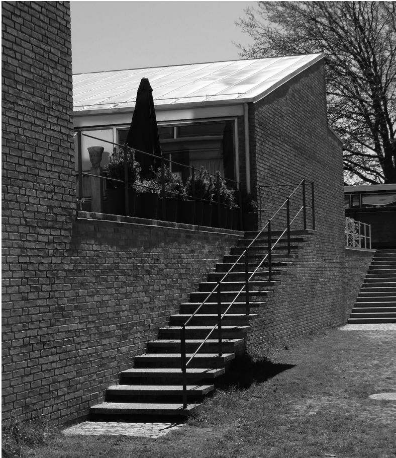
Fachada este. West facade.
